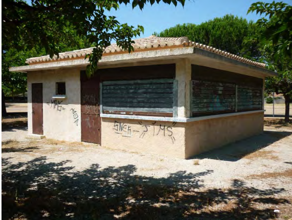
Photo 2 : aménagement central (sanitaires)
